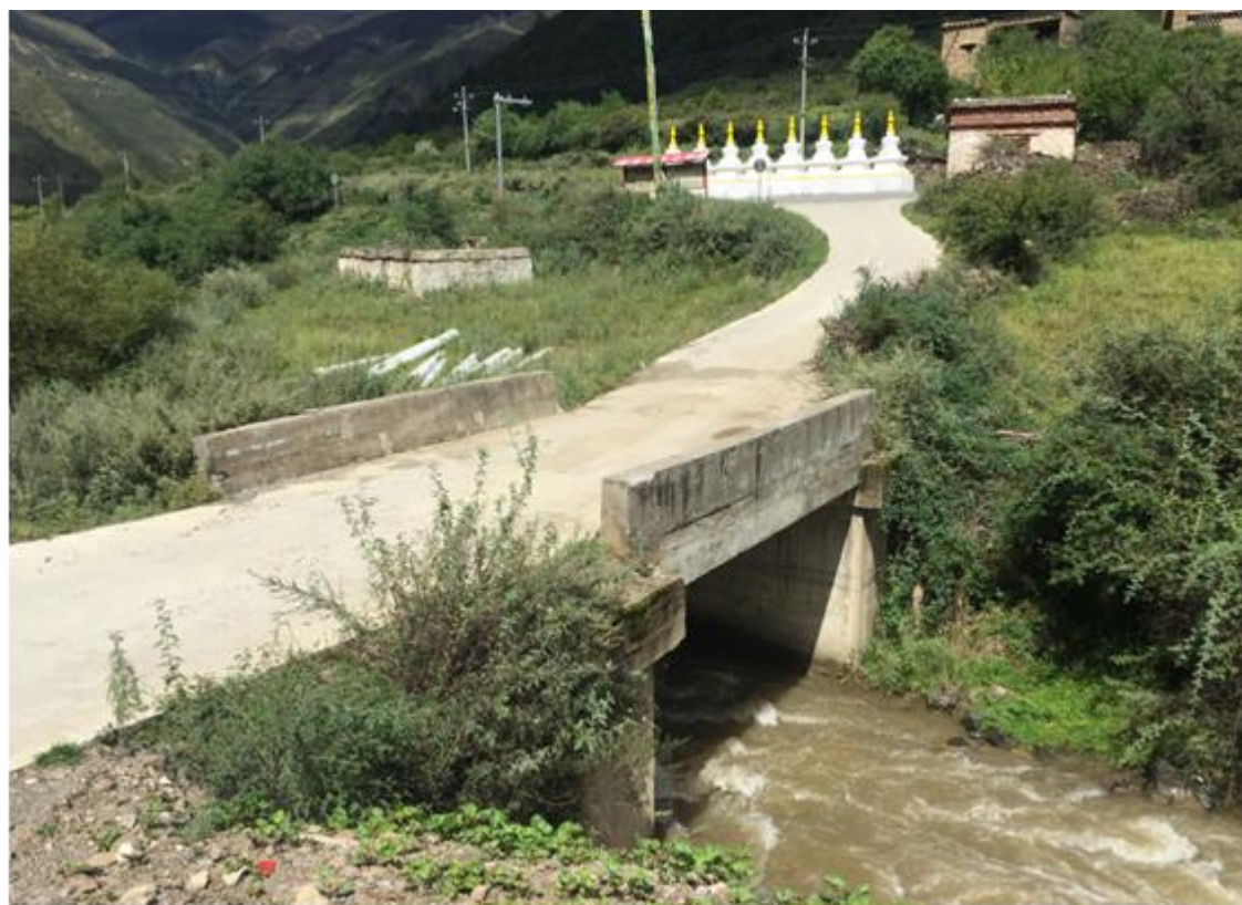
图 1-5：工程河段终点卓亚沟下游 1 号桥
